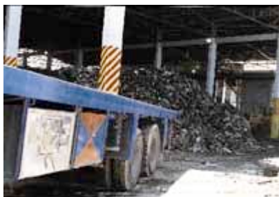
Des déchets souillés et irrécupérables stockés presque jusqu'au plafond.
