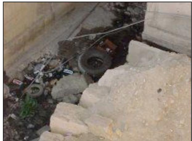
*Dépôts de déchets solides dans le réseau d'évacuation des eaux de pluies et dans les cours d'eau.*
