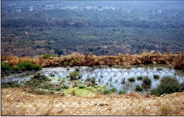
Les bacs de décantation sont creusés à même le sol, qui ne bénéficie d'aucune protection. Aucune paroi n'est en béton et les bacs sont à ciel ouvert. Les problèmes d'infiltration de polluants dans le sol sont donc transférés et concentrés sur une zone à l'écart du village. Les maisons qui ne sont pas raccordées au réseau ne possèdent pas non plus de fosses septiques encore en fonctionnement du fait de leur comblement, les eaux usées se déversant directement dans les jardins.
