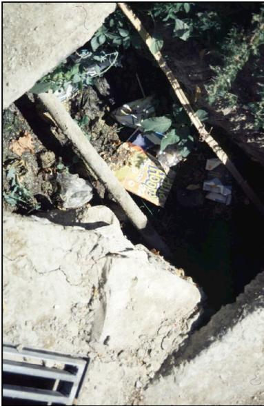
Lorsque l'eau ne s'écoule plus (écoulement gravitationnel) un phénomène d'absorption se produit au niveau des tuyaux de canalisation d'eau potable. Ceux-ci étant situés dans le réseau d'évacuation des eaux de pluies, des polluants s'infiltrent dans les tubes qui desservent ensuite les habitations en eau. Le matériau des canalisations est du fer galvanisé. La vétusté des installations, entre 7 et 8 ans, semble à l'origine de la défectuosité, qui provoque la porosité des canalisations.
