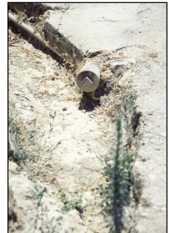
Canalisation de vidange d'une fosse septique débouchant sur le réseau d'eau de pluie -
